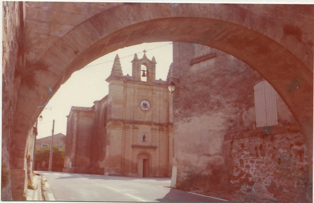
Façade ouest vue à travers l'arche de la passerelle
