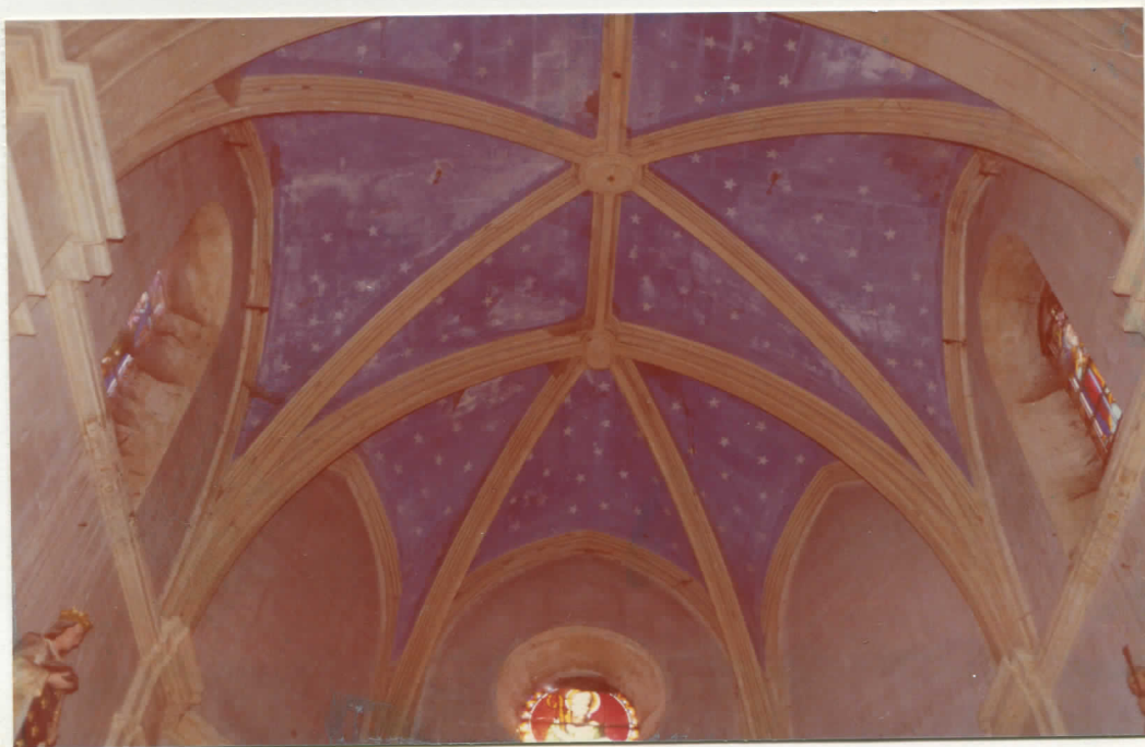
Voûte de l'abside
